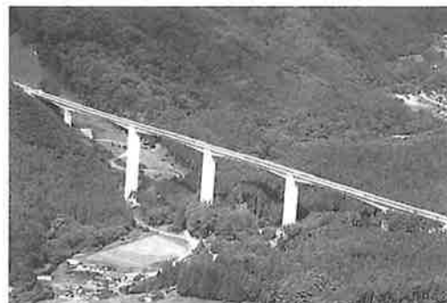
写真-4 PC橋の耐久性向上対策を試行した「越喜来高架橋」
