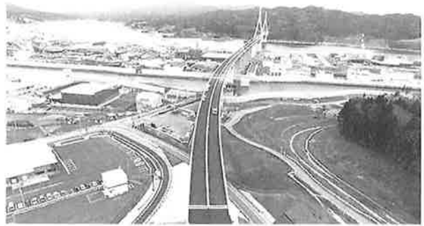
写真-7 RC床版・舗装の耐久性向上対策を試行した「気仙沼湾横断橋」
