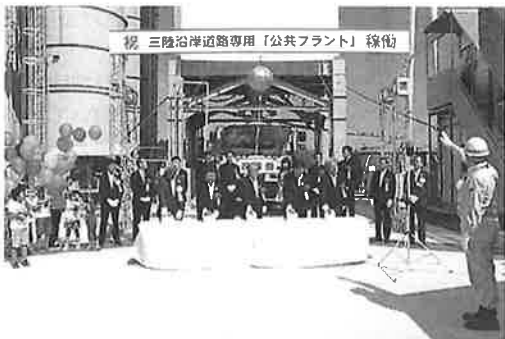
写真-2 公共生コンプラント（宮古市田老地区）
